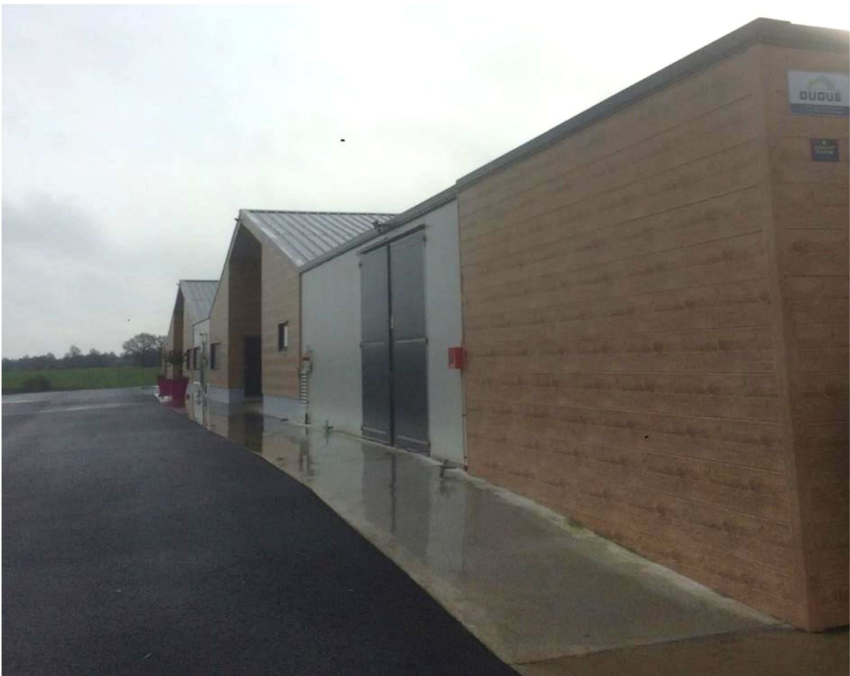
Vue 4 : Vue des pignons des 3 bâtiments
