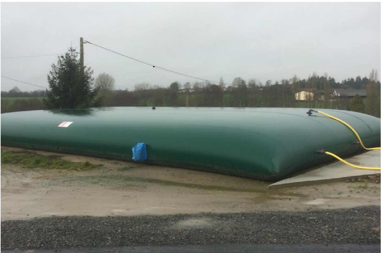
Vue 2 : Vue de la citerne incendie depuis l'entrée
